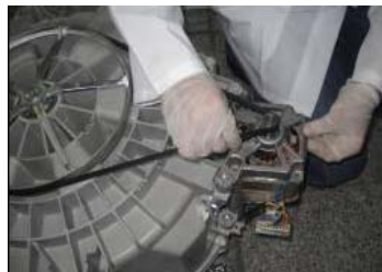
Dévisser les vis de fixation moteur
