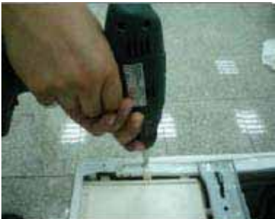
Démonter la trappe d'accès
