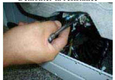
Démonter la résistance
