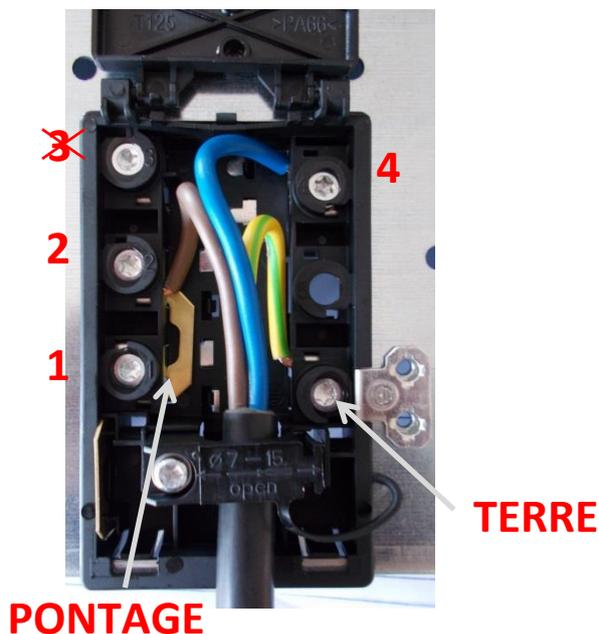
Bornier avec vis cruciforme
