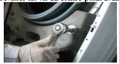
Dévisser l'écrou central fixation résistance (8mm)
