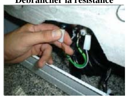
Débrancher la résistance
