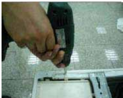
Démonter la trappe d'accès
