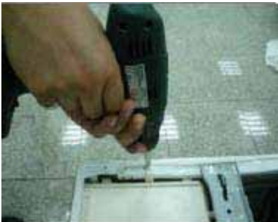
Démonter la trappe d'accès
